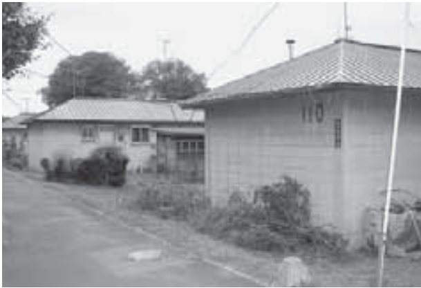
緑町公営住宅
